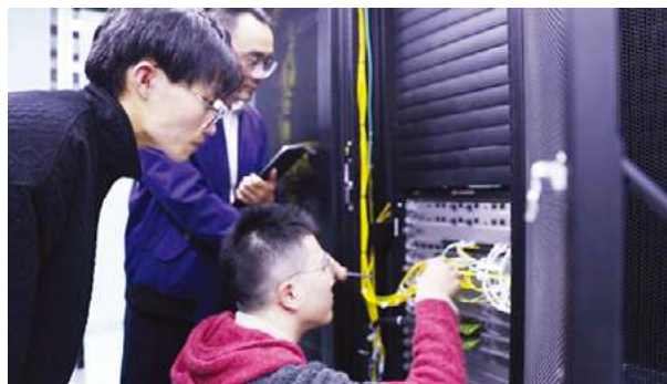
职业教育重视学生的实务操作能力。图为信息技术系学生在数据中心机房实训基地进行网络设备调试与维护操作训练。
