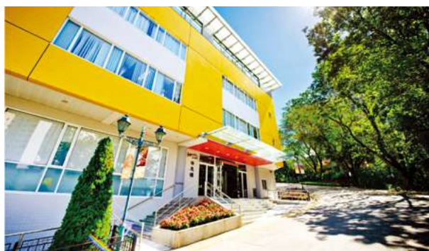
澳门旅游大学教学大楼“启思楼”的外观。
